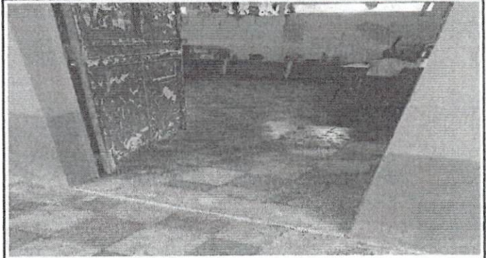
Foto 2: Cambio de Piso Ceramico Aula 1
