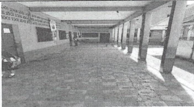
Foto1: Cambio de Piso Ceramico Corredor
