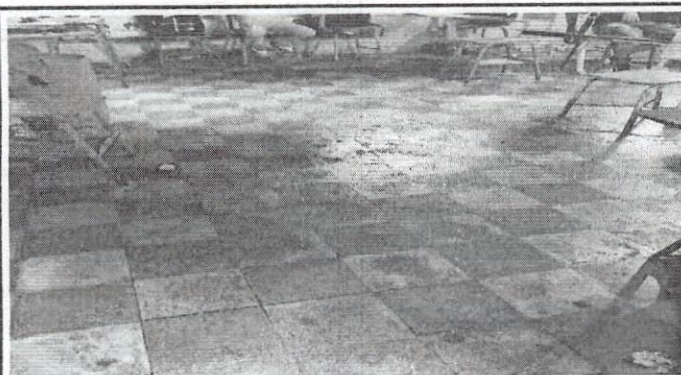
Foto 3: Cambio de Piso Ceramico Aula 2
