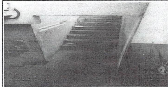
Foto 6: Colacion de Puerta De Metal Aula de Segundo Nivel
